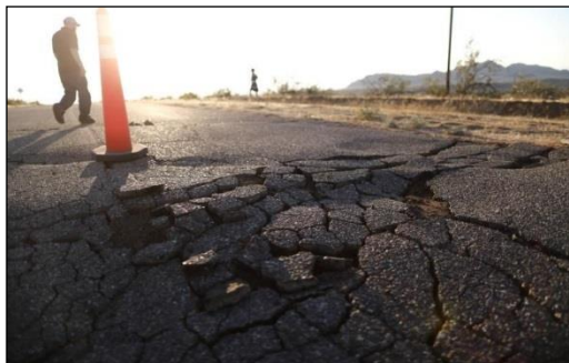
รอยร้าวของถนน เนื่องจากแรงสั่นสะเทือนของแผ่นดินไหว (ที่มารูป : โพสต์ทูเดย์)
