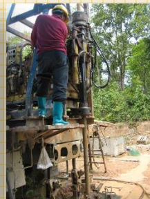
การเจาะสำรวจ และตัวอย่างแท่งหินที่ได้จากการเจาะสำรวจ
