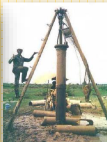
การเจาะสำรวจ และตัวอย่างแท่งหินที่ได้จากการเจาะสำรวจ
