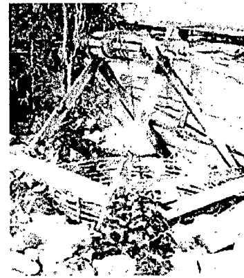
รูปที่ 2 ลักษณะการसानชะลอมไม้ไผ่ลงไปขัดค้ำยันหลุมทดลอง
