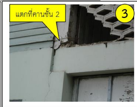
รูปที่ 14-1 อาคารชร017 ต้องรื้อถอน (1) ภาพด้านหลังอาคาร (2) และรอยแตกที่คาน (3) (ถ่ายเมื่อ 23 กค. 57)
