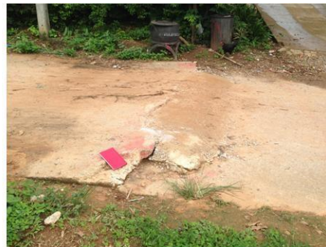
รูปที่ 11-12 ผลการสำรวจด้วยวิธียังลึกด้วยสัญญาณเรดาร์ แนวสำรวจ GPR1 ระยะทาง 330 เมตร ผ่านบริเวณแนวแผ่นคอนกรีตของถนนเลื่อนแยกออกจากกัน
