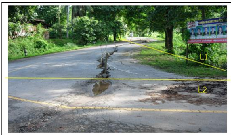
รูปที่ 9-5 ภาพแนวสำรวจ L1, L2 ตัดผ่านรอยแตก (ถ่ายเมื่อ 1 สิงหาคม 2557, มองจากทิศใต้)
