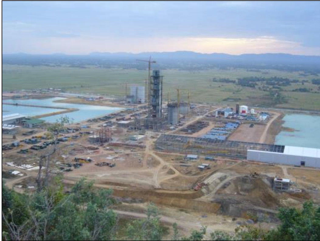
การก่อสร้างโรงงาน
