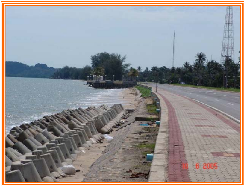
กำแพงกันคลื่นซึ่งจัดเรียงด้วยแท่งคอนกรีต
