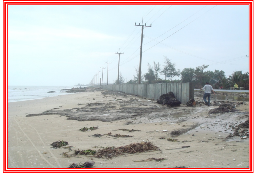
กำแพงกันคลื่นโดยการตอกเข็มฝังเป็นแนว
