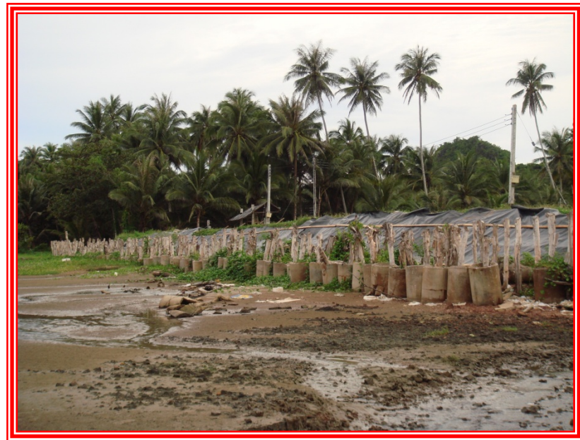
กำแพงกันคลื่นซึ่งจัดเรียงด้วยท่อคอนกรีต
