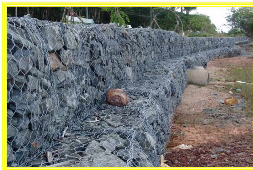
กำแพงกันคลื่นซึ่งจัดทำด้วยตาข่ายท่อหุ้มหิน
