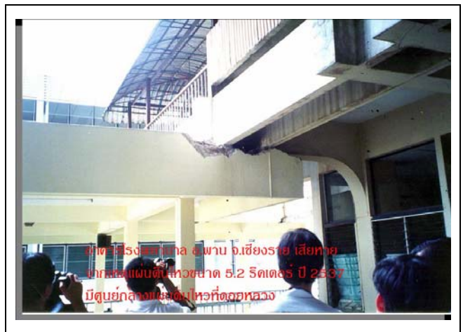
อาคารโรงพยาบาลอำเภอพาน จังหวัดเชียงราย เสียหาย จากแผ่นดินไหวขนาด 5.2 ริกเตอร์ (พ.ศ. 2537)
