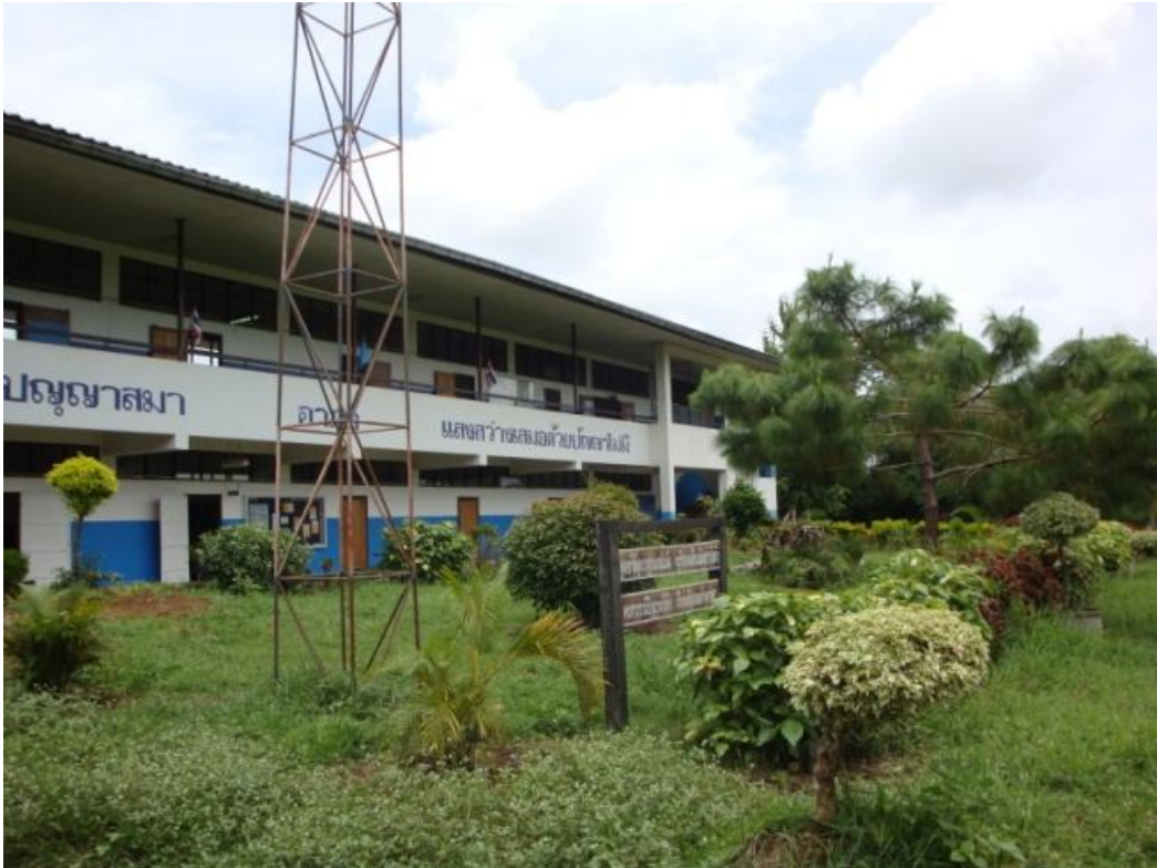
รูปที่ 2 อาคารเรียนที่ทำการจัดแหล่งเรียนรู้ทางธรณีวิทยาโรงเรียนบ้านสุข
