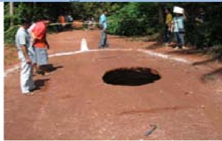
รูปที่ 2.33 หลุมอุบขนาด 2 เมตร ลึก 8 เมตร ที่ อ.ปะเหลียน จ.ตรัง (ซ้าย) หลุมอุบขนาด 4 เมตร ลึก 3 เมตร บนถนนที่อ.คอสสะเค็ด จ.เชียงใหม่ (ขวา) เกิดจากชั้นทรายอุกน้ำใต้ดินที่คืบหา
