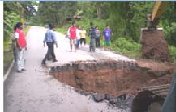
รูปที่ 2.33 หลุมอุบขนาด 2 เมตร ลึก 8 เมตร ที่ อ.ปะเหลียน จ.ตรัง (ซ้าย) หลุมอุบขนาด 4 เมตร ลึก 3 เมตร บนถนนที่อ.คอสสะเค็ด จ.เชียงใหม่ (ขวา) เกิดจากชั้นทรายอุกน้ำใต้ดินที่คืบหา
