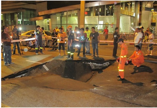
รูปที่ 4-4 เหตุการณ์ถนนพระราม 4 บริเวณใต้สะพานไทย-เบลเยียม ใกล้แยกวิฑู มีการทรุดตัวเป็นหลุมขนาดใหญ่ เมื่อวันที่ 18 มีนาคม 2555 (ที่มา http://www.oknation.net/blog/prompzy/2012/03/18/entry-2 )
