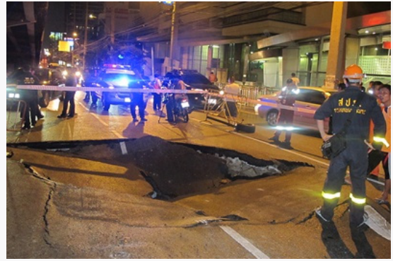
รูปที่ 4-4 เหตุการณ์ถนนพระราม 4 บริเวณใต้สะพานไทย-เบลเยียม ใกล้แยกวิฑู มีการทรุดตัวเป็นหลุมขนาดใหญ่ เมื่อวันที่ 18 มีนาคม 2555 (ที่มา http://www.oknation.net/blog/prompzy/2012/03/18/entry-2 )
