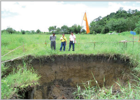
รูปที่ 4-6 ตัวอย่างหลุมยุบบริเวณ บ้านโนนถาวร ตำบล ต่านช้าง อำเภอหนองบัวลำภู จังหวัดหนองบัวลำภู (กรมทรัพยากรธรณี, 2552)
