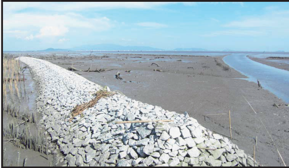
รูปที่ 4-4 โครงสร้างเขื่อนหินริมทะเล บริเวณบ้านคลองเจริญวัย ตำบลสองคลอง อำเภอ บางปะกง จังหวัดฉะเชิงเทรา
