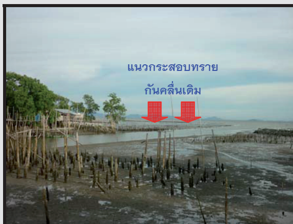
รูปที่ 4-5 สภาพการกัดเซาะชายฝั่งทะเลบริเวณบ้านจันทร์เกษม หมู่ 6 ตำบลสองคลอง อำเภอ บางปะกง จังหวัดฉะเชิงเทรา
