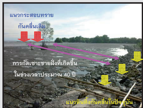
รูปที่ 4-5 สภาพการกัดเซาะชายฝั่งทะเลบริเวณบ้านจันทร์เกษม หมู่ 6 ตำบลสองคลอง อำเภอ บางปะกง จังหวัดฉะเชิงเทรา
