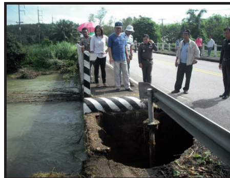
รูปที่ 4-13 น้ำป่ากัดเซาะคอสะพานขาดบริเวณบ้านตำหนัง หมู่ที่ 2 ตำบลบางวัน อำเภอดงทับทิม
