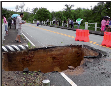
รูปที่ 4-13 น้ำป่ากัดเซาะคอสะพานขาดบริเวณบ้านตำหนัง หมู่ที่ 2 ตำบลบางวัน อำเภอดงทับทิม
