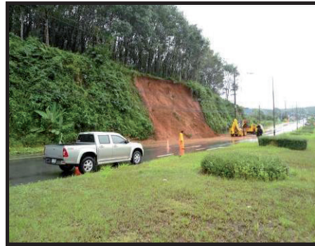
รูปที่ 4-12 สภาพพื้นที่เกิดดินไหลปิดทับถนนเพชรเกษม สายพังงา-โคกกลอย กิโลเมตรที่ 858+150
