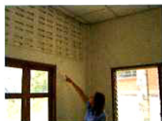
อาคารทำการเชื่อมแม่กวง ต.ลวงเหนือ อ.ดอยสะเก็ด
