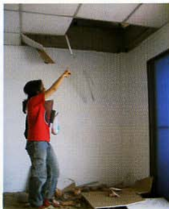
เกิดการพังทลายลงของผนังกันห้อง ที่ก่อด้วยอิฐมวลเบาชั้น ๓ ทำให้ฝ้าเพดานหล่น อ.เชียงของ จ.เชียงราย
