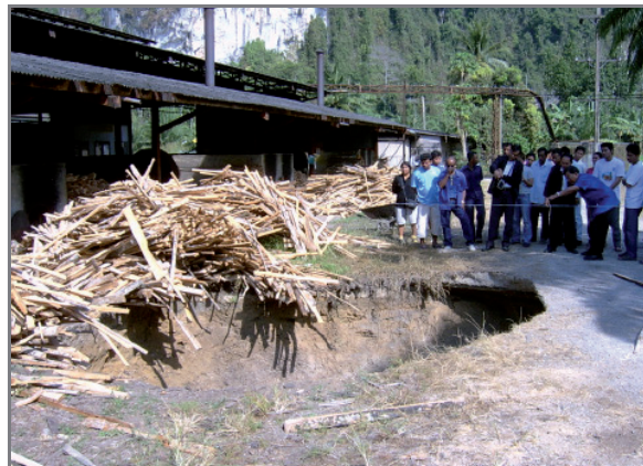
รูปที่ 4-10 ลักษณะหลุมยุบที่เกิดขึ้นจากแผ่นดินไหวขนาด 9.1 ริคเตอร์ เมื่อเดือนธันวาคม 2547 บริเวณโรงงานบริษัทกระป๋องน้ำมันพิซ อำเภ่อ่าวลึก (ปัจจุบันได้ปิดหลุมไปแล้ว)
