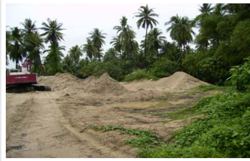
รูปที่ 6-17 กองทรายที่ขุดตักขึ้นมาจากริมคลองหนองหญ้าปล้อง ตำบลชัยเกษม อำเภอบางสะพาน (ตำแหน่งภาพ 556833E/1260480N ทิศทางภาพ-N)
