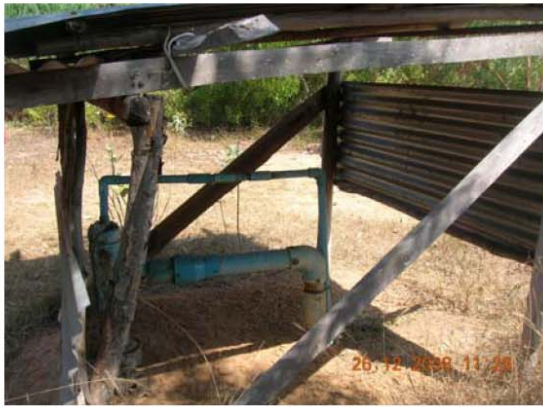
(ก) บ่อสูบน้ำเกลือ เจาะลึกลงไปใต้ดิน 180 เมตร
