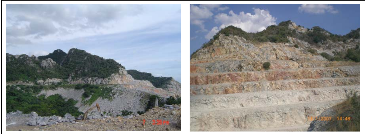
รูปที่ 6-2 แหล่งหินปูนเพื่ออุตสาหกรรมซีเมนต์ บริเวณตำบลหน้าพระลาน อำเภอเฉลิมพระเกียรติ
