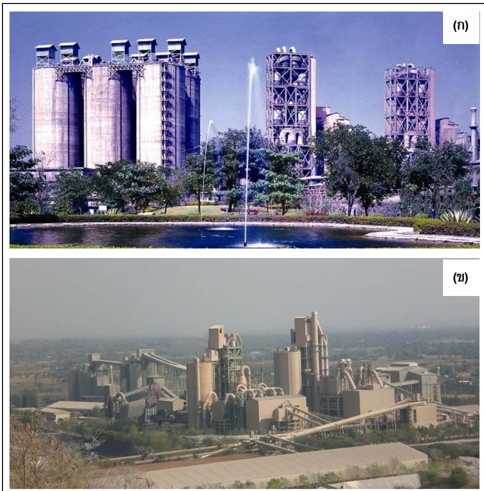
รูปที่ 6-3 โรงงานปูนซีเมนต์ในจังหวัดสระบุรี
