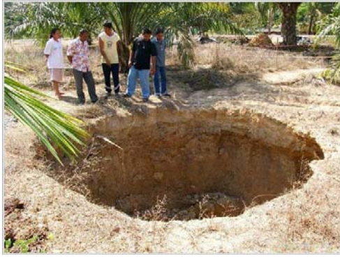
รูปที่ 4-4 หลุมยุบบริเวณ หมู่ 2 ตำบลคีรีวง อำเภอปลายพระยา จังหวัดกระบี่
