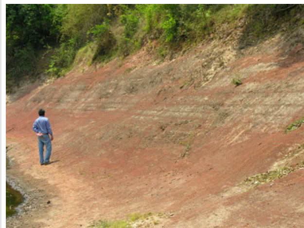
รูปที่ 3-24 แนวการวางตัวของชั้นหิน บริเวณตลิ่งใต้สะพานข้ามแม่น้ำสงครามระหว่างบ้านห้วยสงคราม อำเภอโซ่พิสัย จังหวัดหนองคายกับบ้านเหล่าสมบูรณ อำเภอบ้านม่วง จังหวัดสกลนคร (0338243 E/1991470 N, 5645 II) เอียงเทไปทางทิศตะวันตกเฉียงใต้
