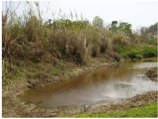
รูปที่ 6-11 ร่องรอยขุมเหมืองถ่านหินเก่า บริเวณแหล่งถ่านหินผาเวียง ตำบลนาแก อำเภอนาวัง (ค่าพิกัด 190539E/1933123N ทิศทางภาพ-W)
