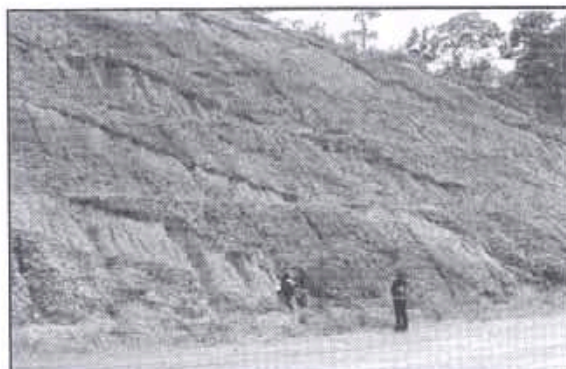
รูปที่ 3-3 ชั้นกรวด กม. 55 (เส้นทาง อ.เวียงป่าเป้า - อ.วังเหนือ)
