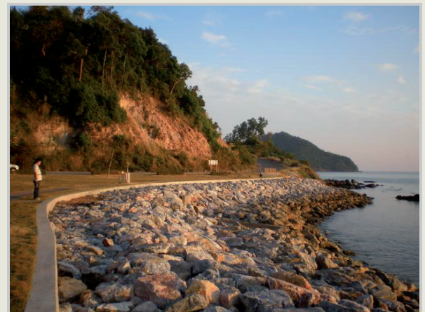
รูปที่ 5-28 เขื่อนป้องกันการกัดเซาะชายฝั่ง บริเวณอ่าวคู้วิมาน
