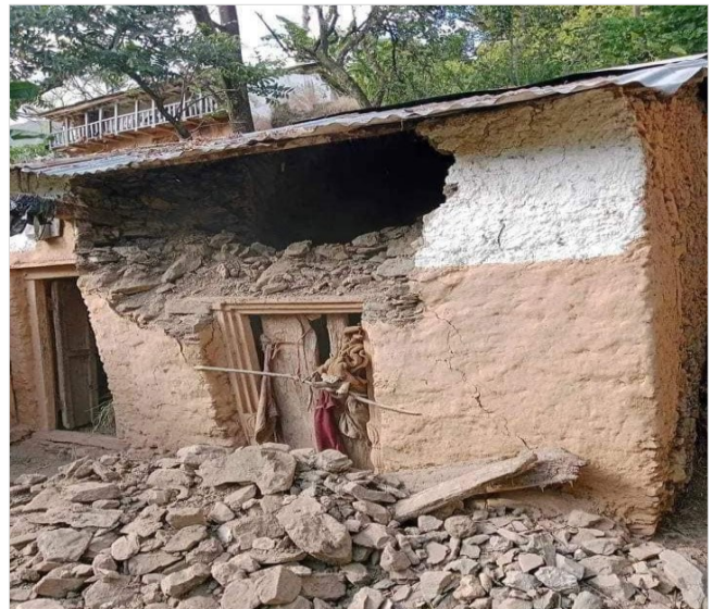
ผลกระทบจากเหตุการณ์แผ่นดินไหวขนาด 5.7 บริเวณประเทศเนปาล (ที่มา : Awalokkan Sikkim)
