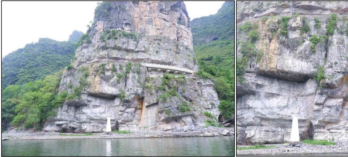
รูป แสดงการติดตั้งอุปกรณ์ป้องกันหินร่วงในบริเวณที่มีความเสี่ยง
