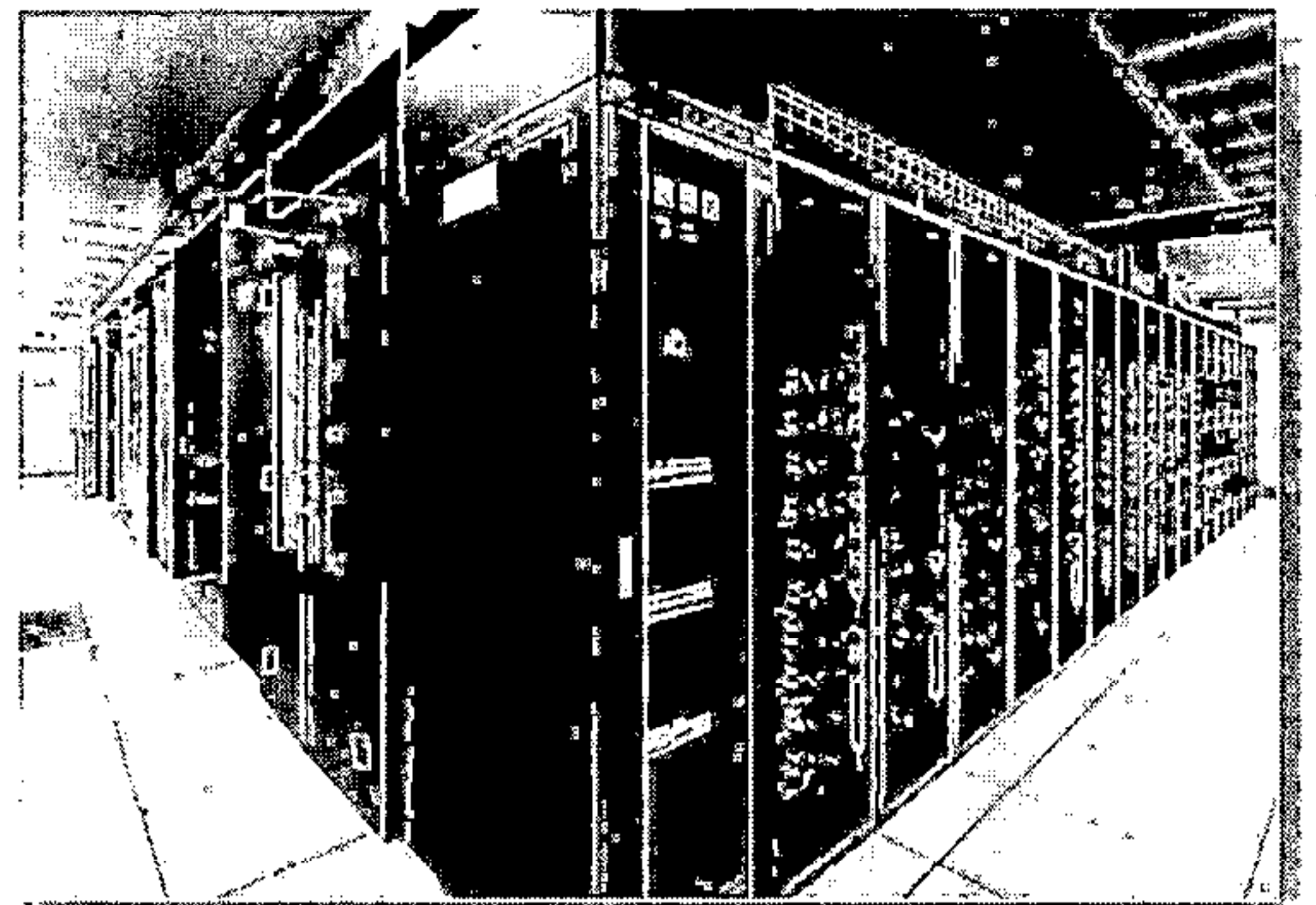
Computing Power Center 超算中心
