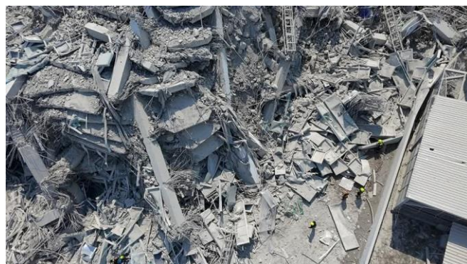
ภาพความเสียหายของอาคารสำนักงานตรวจเงินแผ่นดิน (แห่งใหม่) บริเวณย่านจตุจักร ซึ่งในอาคารมีคนงานประมาณ 50 ราย สามารถหนีออกมาได้ 7 ราย ติดในอาคาร 43 ราย ทางศูนย์เรนทส พล. กำลังเร่งเข้าพื้นที่เพื่อช่วยเหลือ พร้อมเครือข่ายกู้ชีพ (ที่มา : กรมป้องกันและบรรเทาสาธารณภัย)
