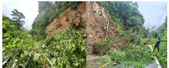
แผ่นดินถล่มบริเวณทางหลวง 1194 แม่สะเรียง-แม่สามแลบ อำเภอสบเมย จังหวัดแม่ฮ่องสอน (ที่มา : กรมป้องกันและบรรเทาสาธารณภัย)
