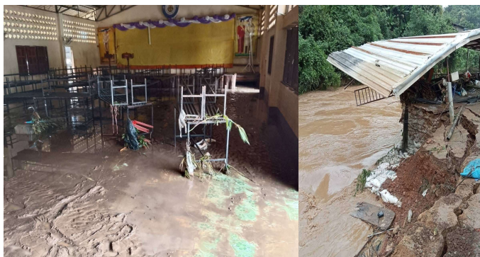
น้ำป่าไหลหลากบริเวณพื้นที่ตำบลแม่นางจร ตำบลท่าผา และตัวอำเภอแม่แจ่ม จังหวัดเชียงใหม่
