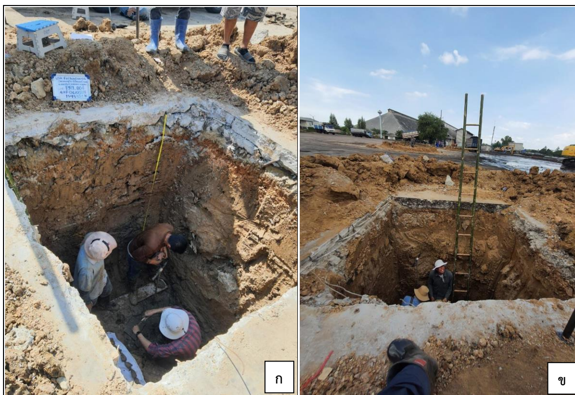
รูปที่ 6 (ก และ ข) ลักษณะหลุมสำรวจที่ใช้รถขุดดิน ตัด และเปิดหลุมกว้างประมาณ 2 เมตร ยาวประมาณ 2 เมตร จนถึงชั้นดินธรรมชาติ ทั้งนี้การขุดจะต้องทำให้ผนังหน้าหลุมเรียบ เพื่อให้สามารถศึกษาตะกอนได้สะดวก ก่อนทำการเจาะสำรวจด้วยเครื่องเจาะชนิดมือหมุนต่อไป
