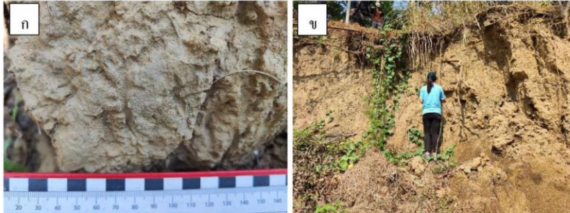
รูปที่ 8 ลักษณะชั้นดินที่พบบริเวณพื้นที่ดินทรุดตัว (ก) ดินชนิดทรายแป้งปนดินเหนียวในบริเวณพื้นที่ดินทรุดตัว (ข) ชั้นดินมีความหนามากกว่า 7 เมตร
