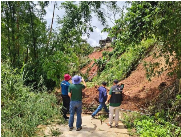
การตรวจสอบแผ่นดินถล่ม อำเภอแม่ฟ้าหลวง จังหวัดเชียงราย
