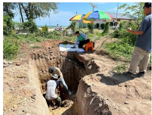
ตรวจสอบสภาพพื้นที่ที่ขุดออกโฉนดที่อกริมตลิ่ง อำเภอเมืองระยอง จังหวัดระยอง
